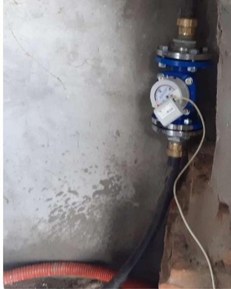
**Figura 7.** Rilevatore consumi idrici (Azienda Stradiotti).
